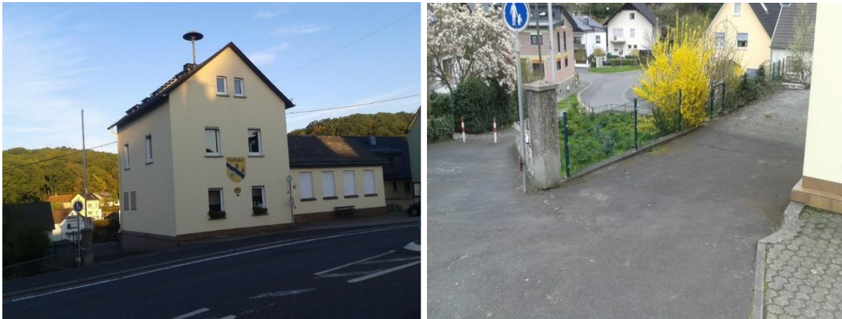
Abbildung 16: Ansicht Rathaus und Blick vom Rathaus hinab auf die Kreuzung Dorfstraße/Bachstraße
