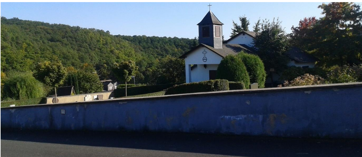
Abbildung 50: Blick auf die sanierungsbedürftige Mauer am Friedhof
