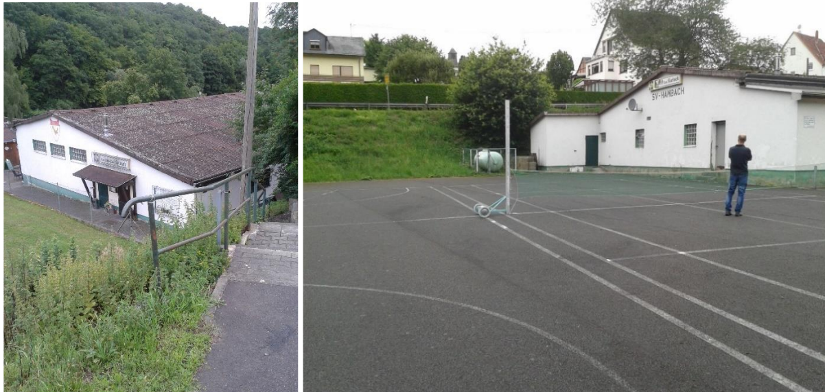
Abbildung 12: Eindrücke der stark sanierungsbedürftigen Sporthalle
