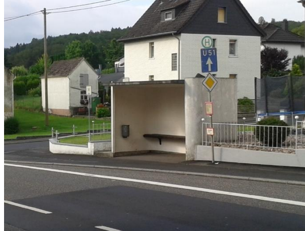
Abbildung 43: Aktueller Zustand der Bushaltestelle Koblenzer Straße
