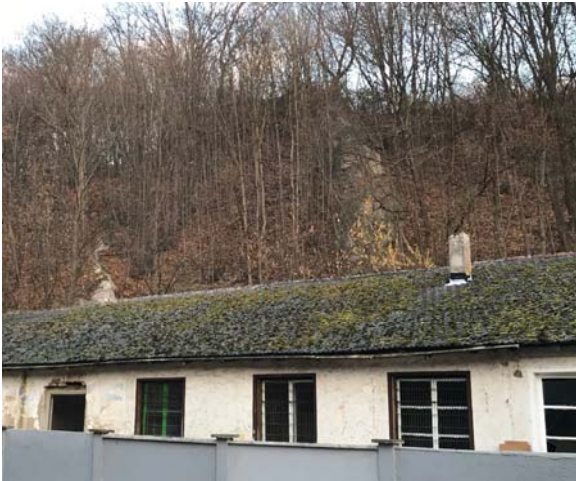
Bild 6: Felsrippe im Böschungsbereich westlich des Projektareals (30.11.2020)
