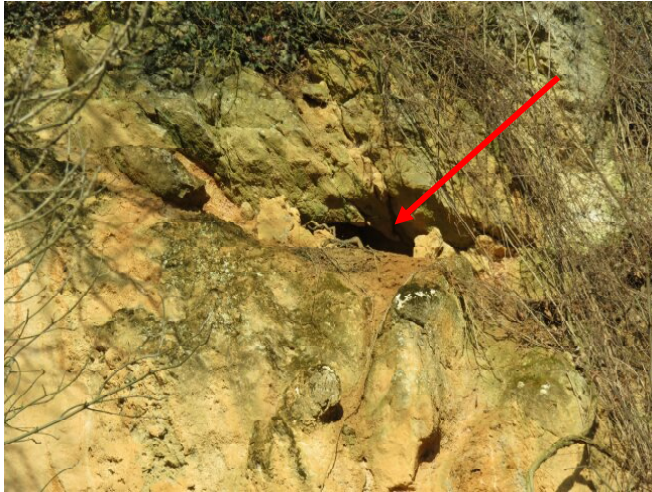
Abb. 9: größerer Spalt in Felswand
