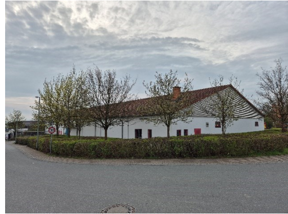
Abbildung 3: Blick aus Nordwesten auf die Rückseite des NORMA-Marktes.
