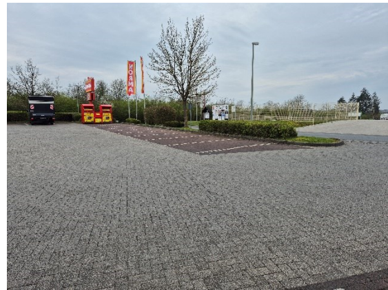
Abbildung 5: Westlicher Blick auf den Parkplatz.
